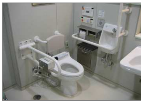
多目的トイレの例
