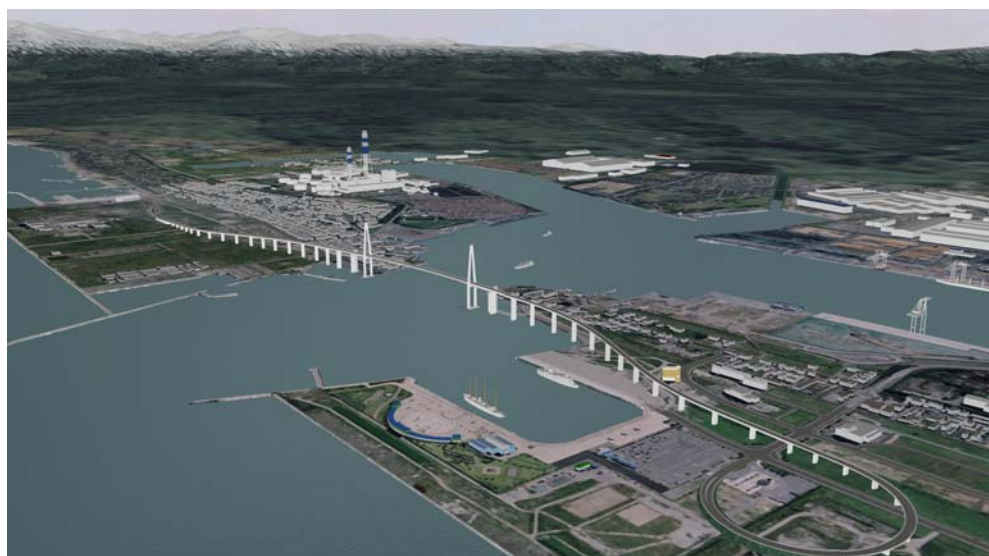
完成が待たれる新湊大橋（仮称）
