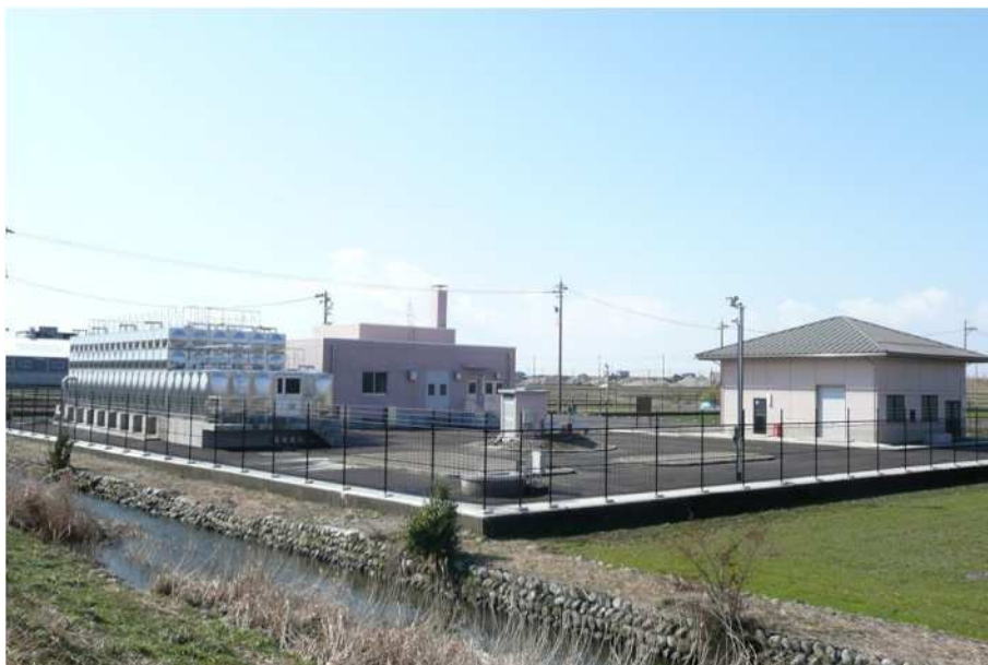
写真：広上取水場
