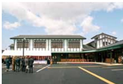
■塚原公民館竣工
