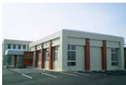
■二口公民館竣工
