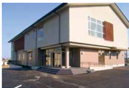
■浅井公民館竣工
