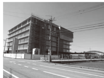
庁舎新築工事 外部の様子
