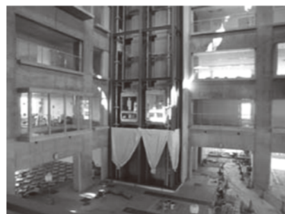
庁舎棟内部の様子▶
