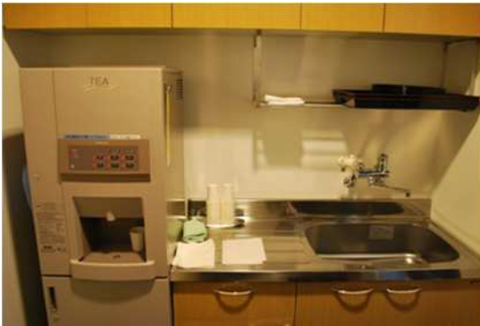
待合室に給茶機を設置（宇都宮市悠久の里）
