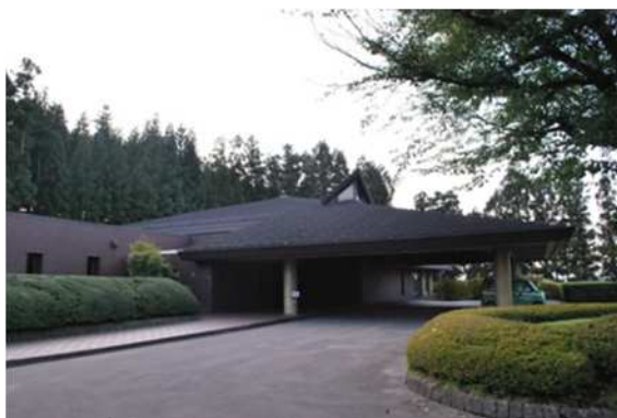
大屋根方式とした車寄せ（弘前市斎場）
