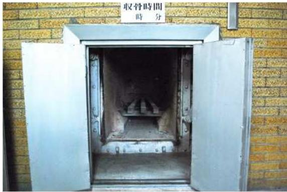
写真 7 火葬炉内（ロストル式に改修）
