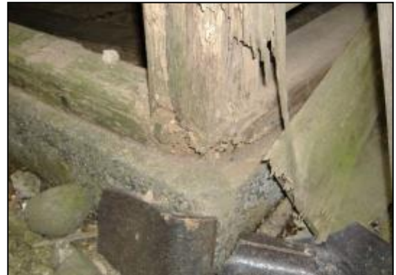
柱・土台の腐朽
