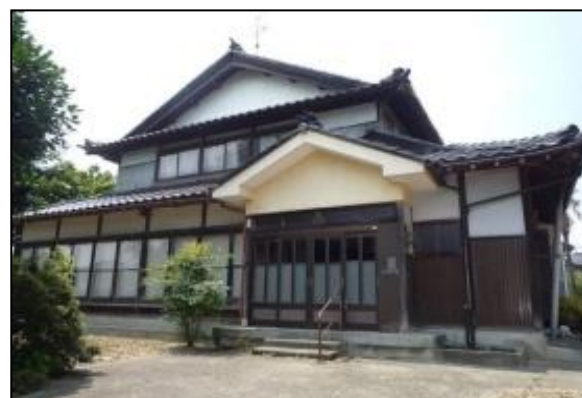
目立った損傷なし
