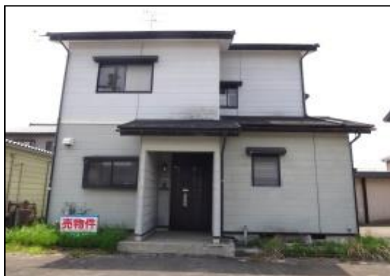
目立った損傷なし
