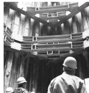
▲ 大門大島雨水幹線整備事業施工箇所
