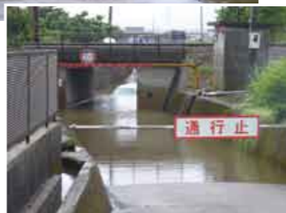
▲水没した車(大島)
