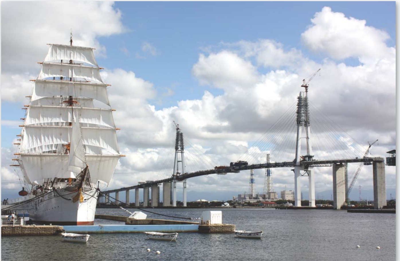
海王丸と建設が進む新湊大橋
