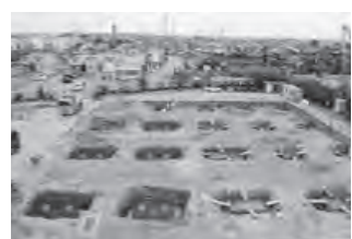
②基礎配筋・コンクリート 打設工事施工中 (平成26年8月上旬撮影)
