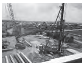
①杭工事施工中 (平成26年6月下旬撮影)
