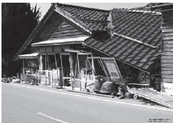
平成19年能登半島地震による家屋の被害
