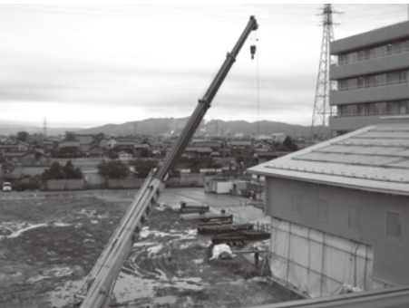
厚生棟新築工事(撮影：H28.7 下旬)
