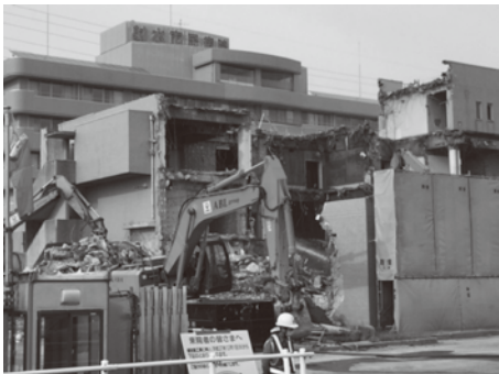
旧診療棟の解体(撮影：H28.5 中旬)
