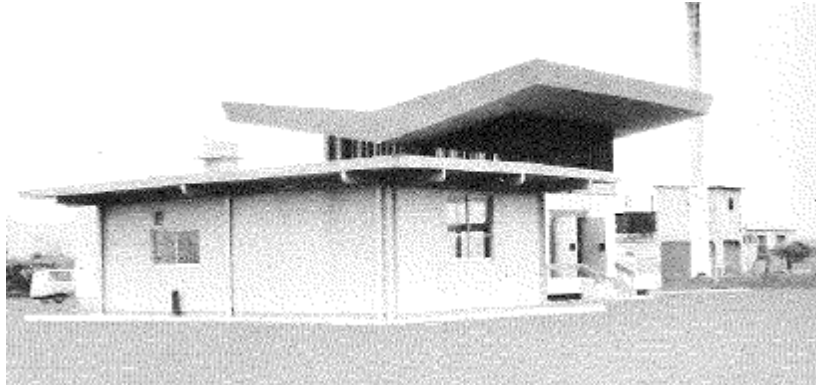
写真 1 竣工当初外観
