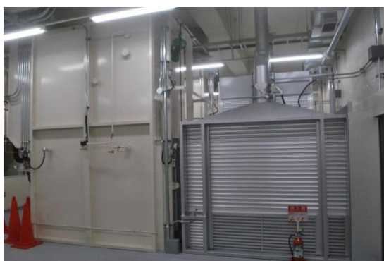
写真 35 前室付火葬炉設備
