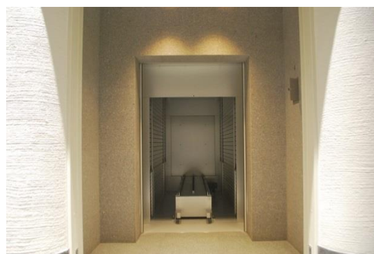
写真 36 火葬炉前室内部
