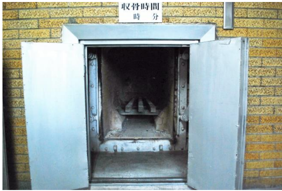
写真 7 火葬炉内 (ロストル式に改修)
