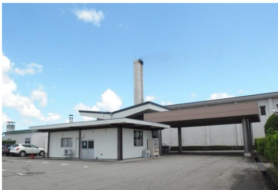
写真 3 火葬棟及び待合棟外観
