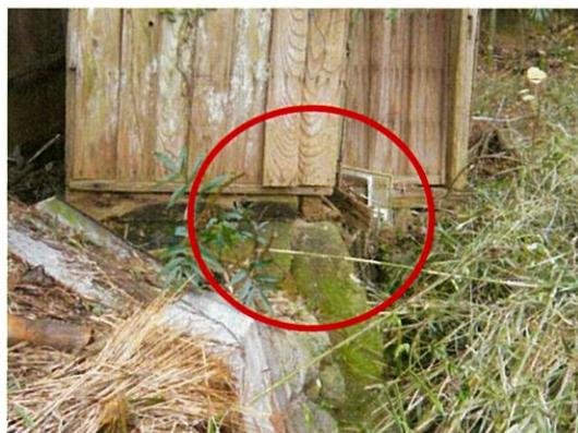
土台が腐朽して欠損している
