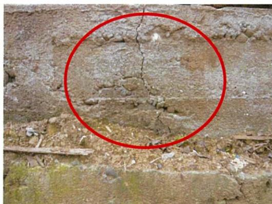
基礎にひび割れが発生している
