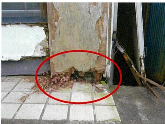
柱脚が腐朽し欠損している
