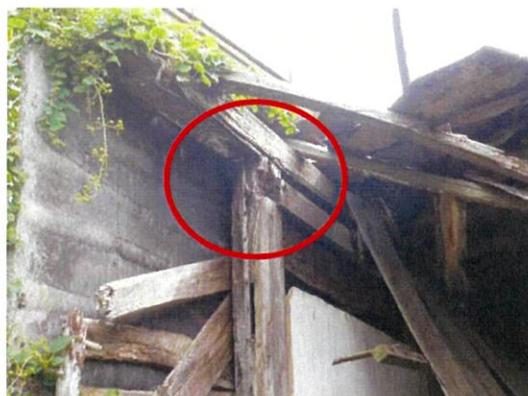
はりの腐食により欠損している
