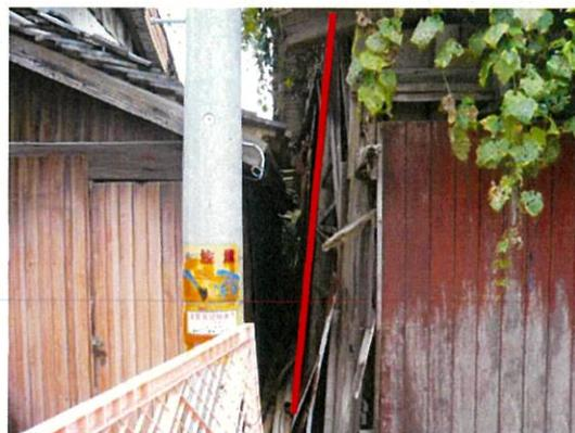
柱が傾斜している
