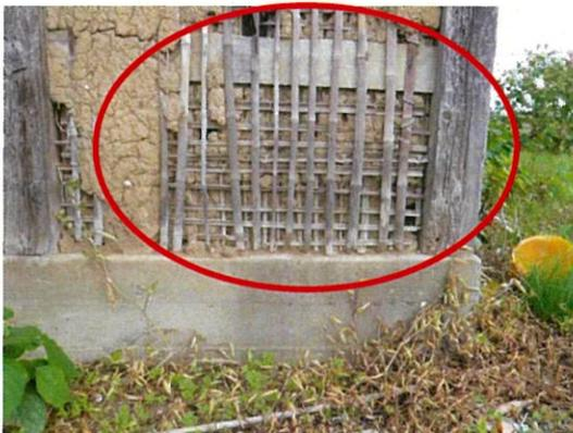
外壁材が剥がれて土壁が露出
