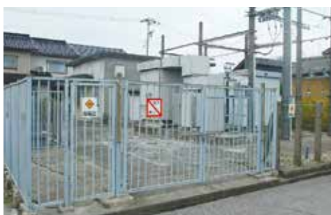
西新湊変電所
