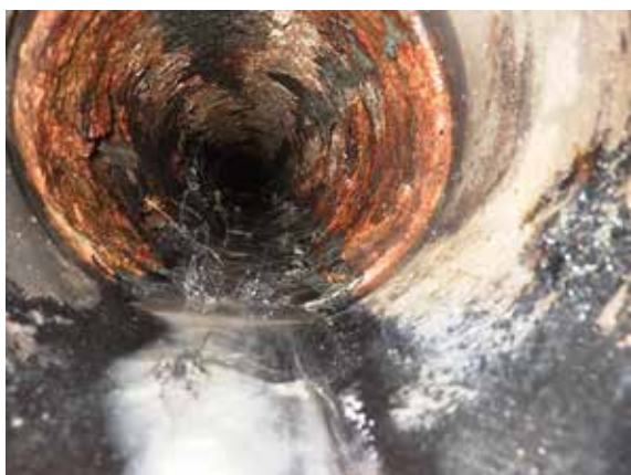
老朽化した污水管渠内
