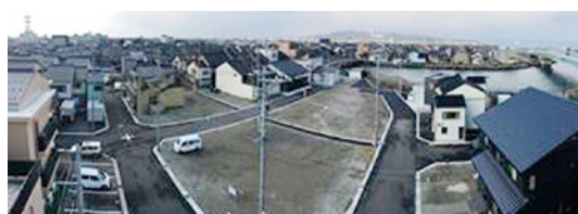
施行後（老朽建築物除却後） (平成30年度撮影)
