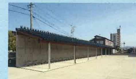
JR氷見線氷見駅周辺駐輪場整備(氷見市) (平成27年度都市再生整備計画事業)
