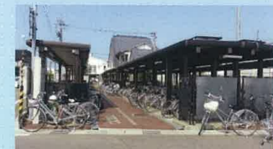
あいの風とやま鉄道首留町駅周辺駐輪場整備(高岡市) (平成25年度都市再生整備計画事業)
