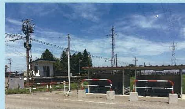
富山地铁田添駅駐輪場(立山町) (平成27年度県補助事業)
