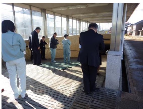
まち歩き点検（小杉駅地下道）
