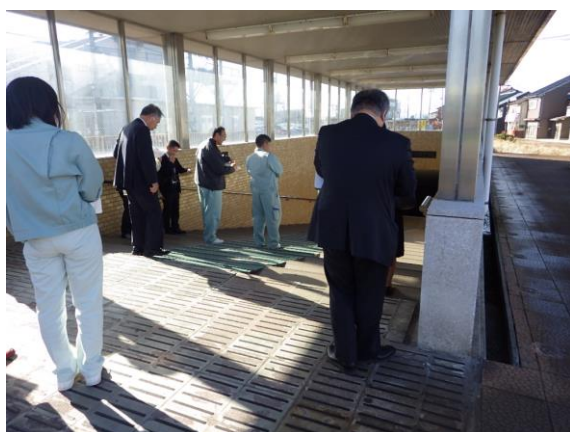
まち歩き点検（小杉駅地下道）
