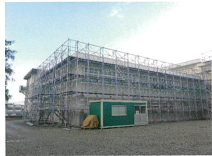
*校舎棟の改修工事
