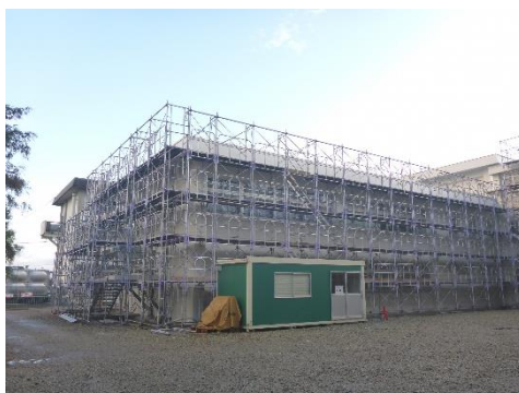
* 校舎棟の改修工事
