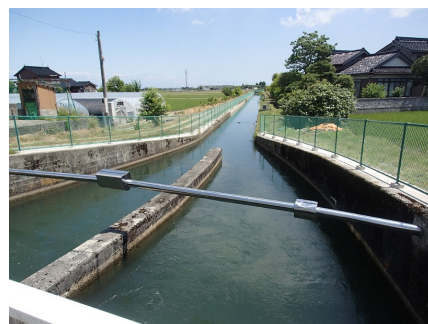
用水路・排水路
