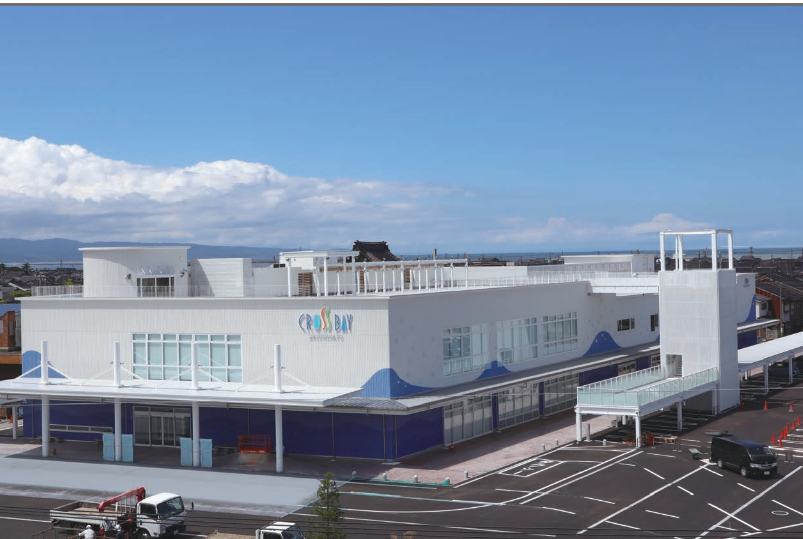
クロスベイ新湊（旧新湊庁舎跡地）8月1日竣工（撮影は7月16日）
