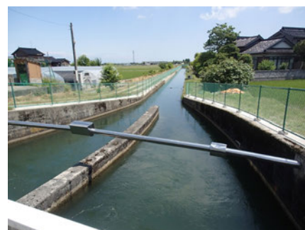
用水路・排水路
