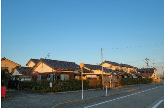
中村（公営住宅4戸、改良住宅2戸、大門）
