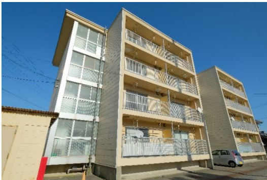
港町（公営住宅12戸、新湊）
