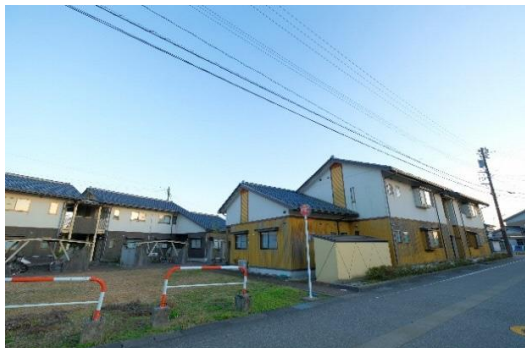
大門（公営住宅12戸、大門）
