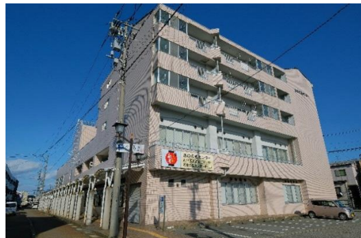
立町（公営住宅11戸、特定公共賃貸住宅7戸、新湊）
