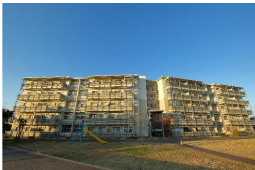
赤井（公営住宅16戸、特定公共賃貸住宅24戸、大島）
