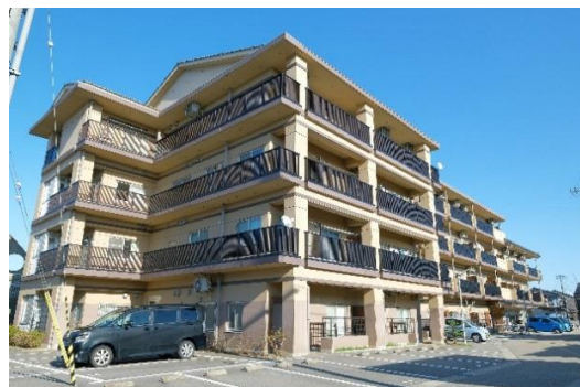
リアン放生津（都市再生住宅18戸、新湊）
