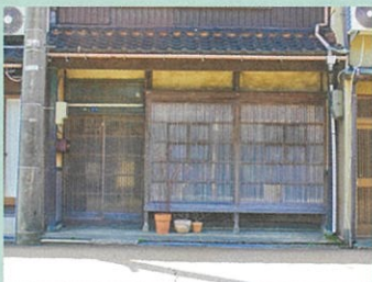
伝統的家屋の特徴の一つ、さまのこ。プライバシーを守りながら光を採る構造。(千本格子)
