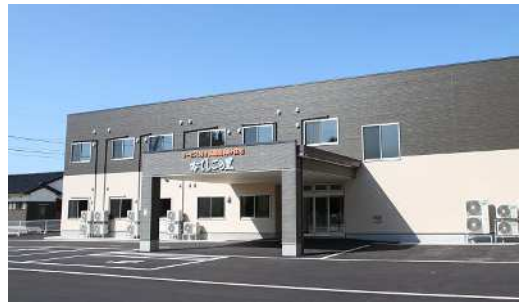
市内サービス付き高齢者向け住宅の例 （出典）なでしこの里ホームページ
