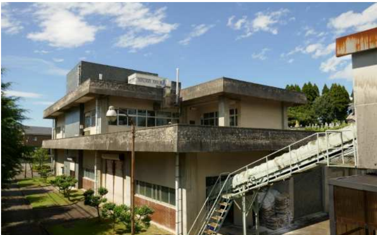
図 1-1 太閤山浄化センター外観
