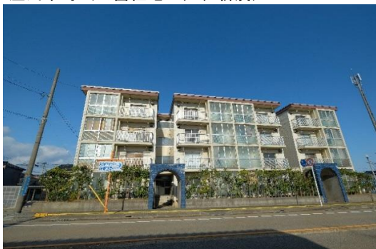
庄川本町（公営住宅16戸、新湊）
