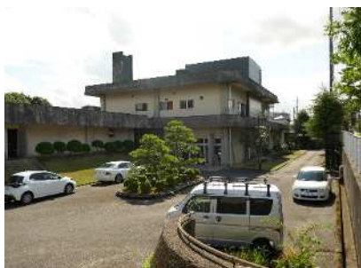
西側進入路から見たセンター外観
