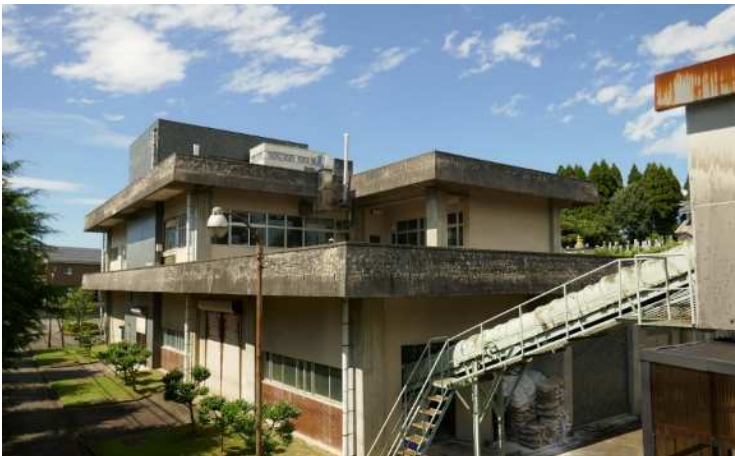
図 1-1 太閤山浄化センター外観
