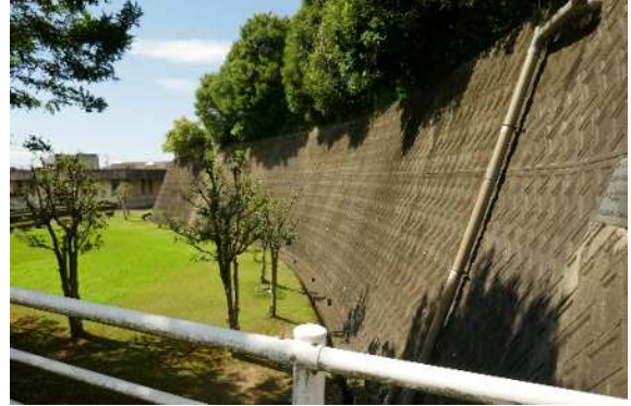
隣接地との間の擁壁
