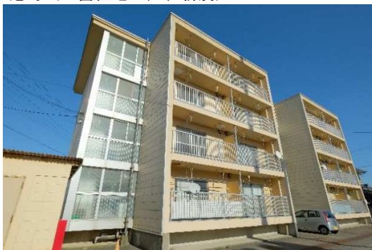
港町（公営住宅12戸、新湊）
