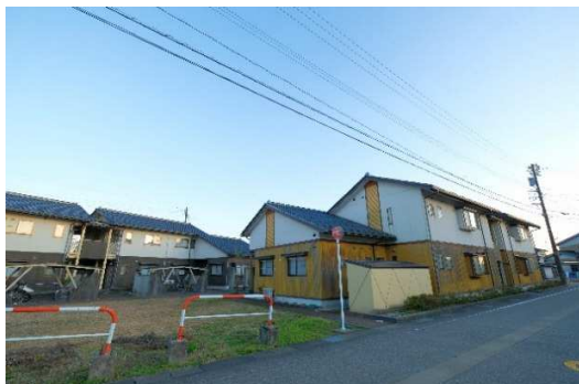
大門（公営住宅12戸、大門）
