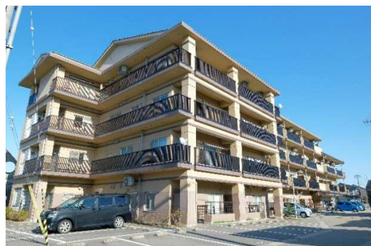
リアン放生津（都市再生住宅18戸、新湊）
