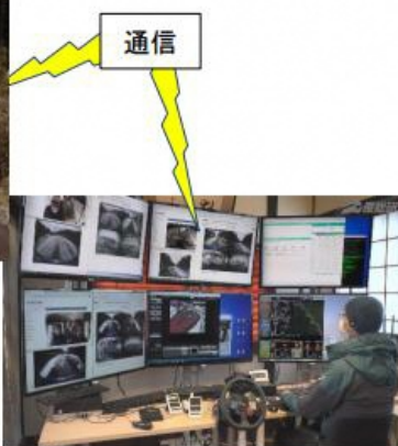
遠隔監視・操作室
