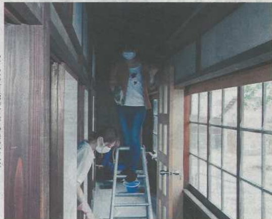
空き家の古民家再生で掃除や大工作業に奮闘する学生ら＝南砺市福光で
