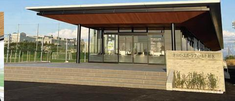
鉄骨造平屋建て 延床面積: 約580㎡
