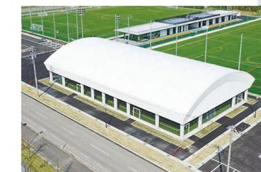
鉄骨造平屋建て 延床面積: 約1,125㎡
