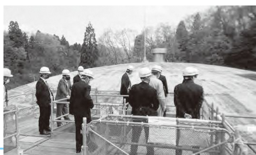
鳥越調整場 低区調整池
