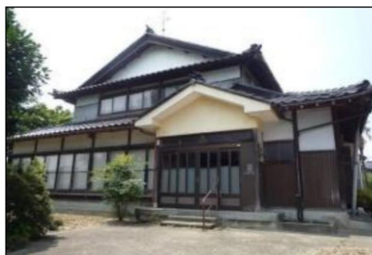
目立った損傷なし
