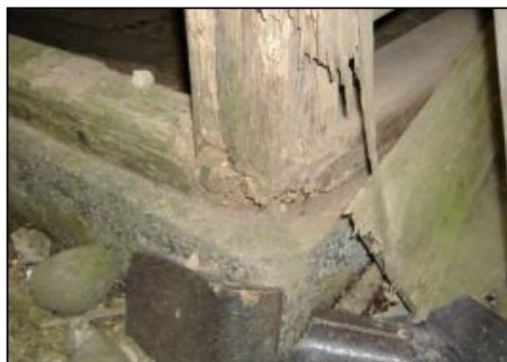
柱・土台の腐朽
