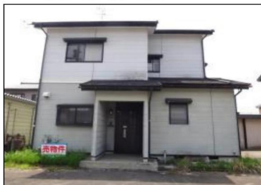
目立った損傷なし
