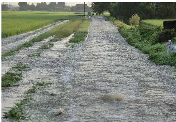
針山口六ヶ用水路 溢水状況(H26.7 豪雨)
