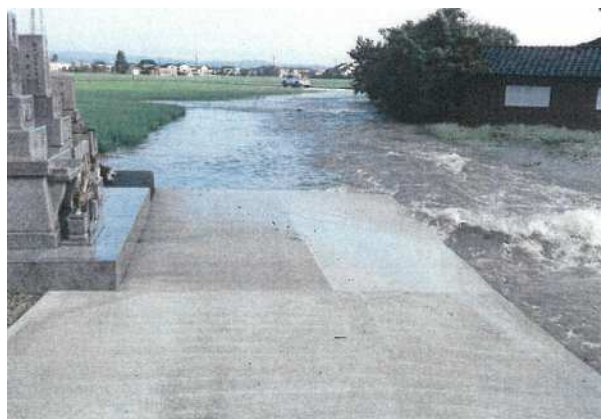
道路の冠水状況
