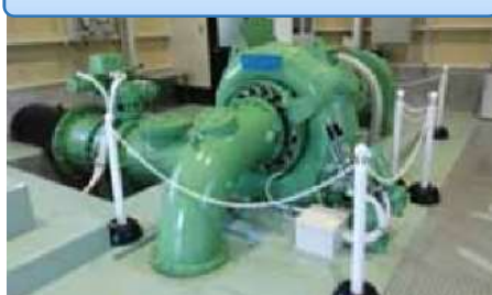
水車発電機（横軸フランシス）
