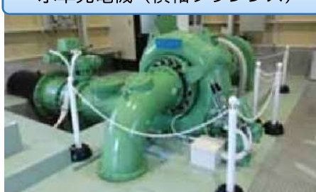
水車発電機（横軸フランシス）
