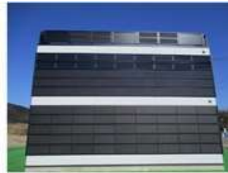
建物側壁・窓
