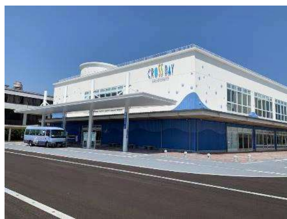
クロスバイ新湊 外観
