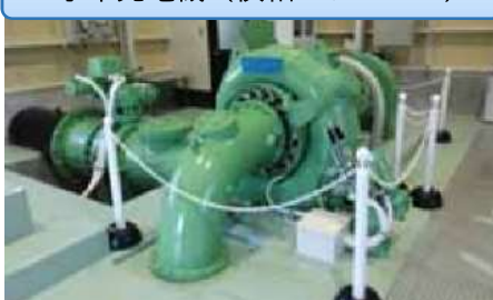
水車発電機（横軸フランシス）
