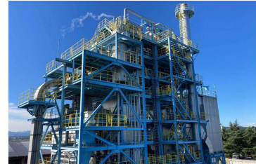
【木質バイオマス施設の外観】
