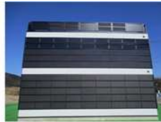
建物側壁・窓
