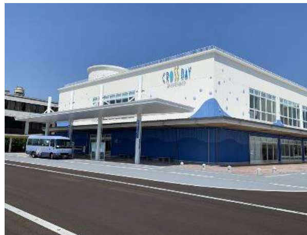
クロスバイ新湊 外観
