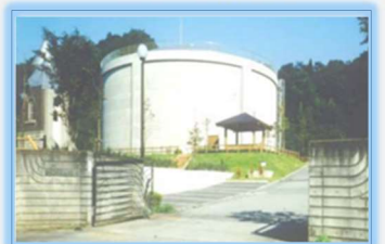
水道施設における水力発電に検討 (写真：射水市鳥越調整場)
