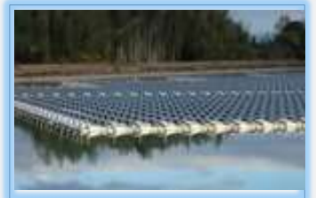
水上設置型太陽光発電設備
