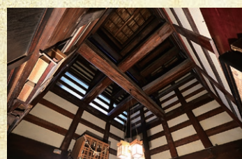
茶の間吹抜け小屋組
