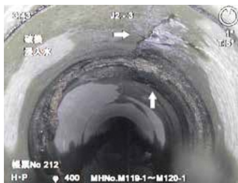
老朽化した汚水管渠内
