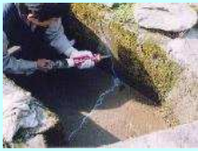
水路のひび割れ補修
