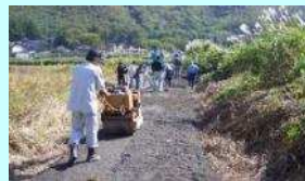
未舗装の農道をアスファルトで舗装
