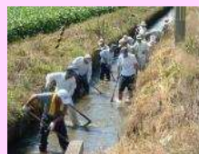
水路の泥上げ
