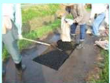
農道の部分補修
