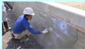
老朽化した水路壁のコーティング
