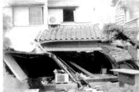
耐力壁の不足で傾斜した住宅
