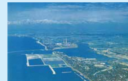
着工前の海王丸パーク周辺 （富山新港西埋立地）
