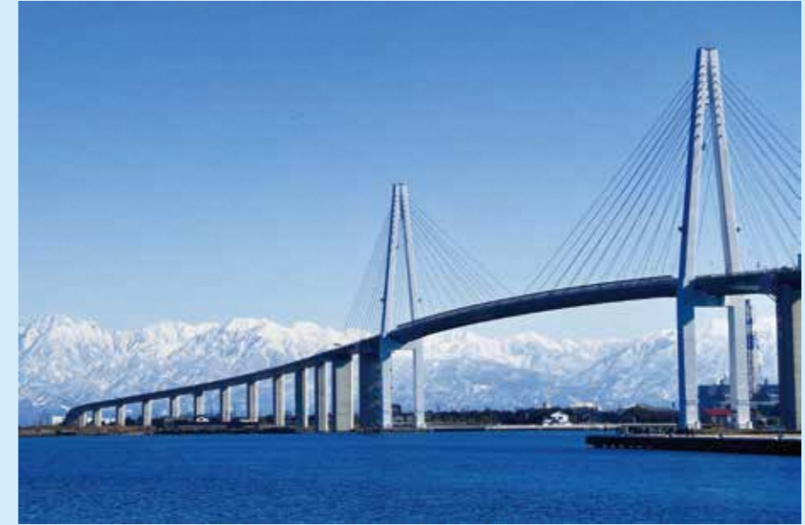
9月 新湊大橋が開通 富山新港に架かる日本海側最大の2層構造の斜張橋、新湊大橋が開通。夜間は午後10時頃までライトアップ。
